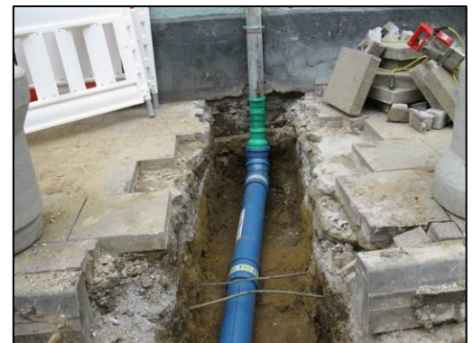
rechts: Erneuerung einer Regenwasserleitung in offener Bauweise
