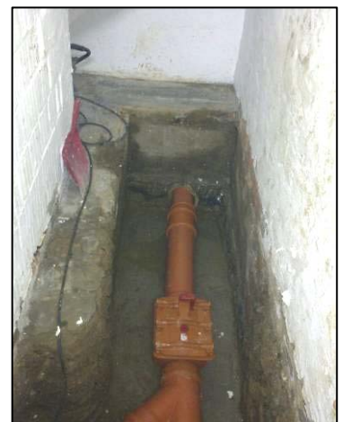
Abb.: eine erneuerte Abwasserleitung im Kellergeschoss
