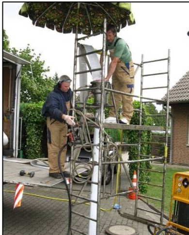
Abb.: Einbau eines Schlauchliners mit größerem Durchmesser (Anlagen für den Gebrauch innerhalb eines Gebäudes sind entsprechend kleiner)
