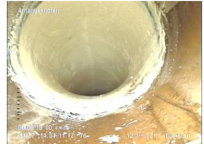
Abb.: verklebter Kurzliner in einem Abwasserrohr
