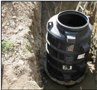
Abb.: Nachrüstung mit einem Kunststoffschacht
