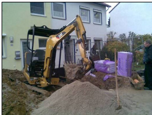
links: Baggerarbeiten auf dem Grundstück
